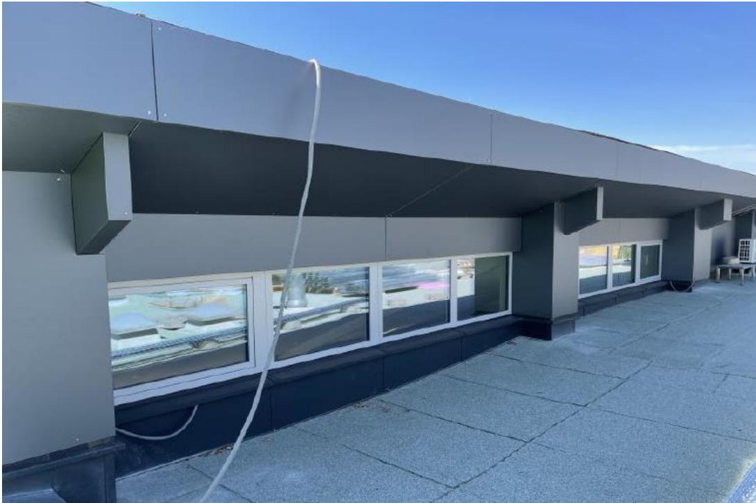
Sowie am Bild ersichtlich wird die Fassade und Holzslatenteile der Sporthalle inkl. Hort oben am Flachdach mit Aluminiumplatten verkleidet. Diese Arbeiten sind im Hauptauftrag enthalten.
